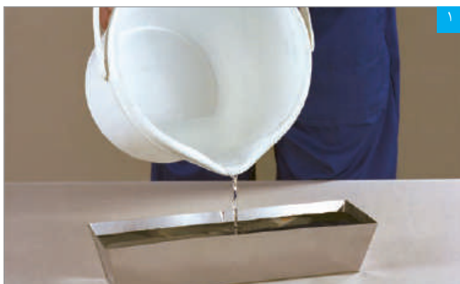
ریختن آب در ظرف تهیه بتونه
