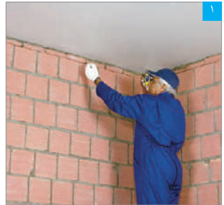
۱ مشخص کردن محل نصب سازه هادی سقف با ریسمان رنگی
