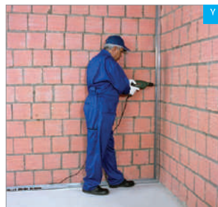
نصب اولین استاد بر روی ساختار جانبی
