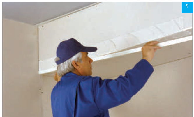
قرار دادن نوار درزگیر بر روی بتونه
