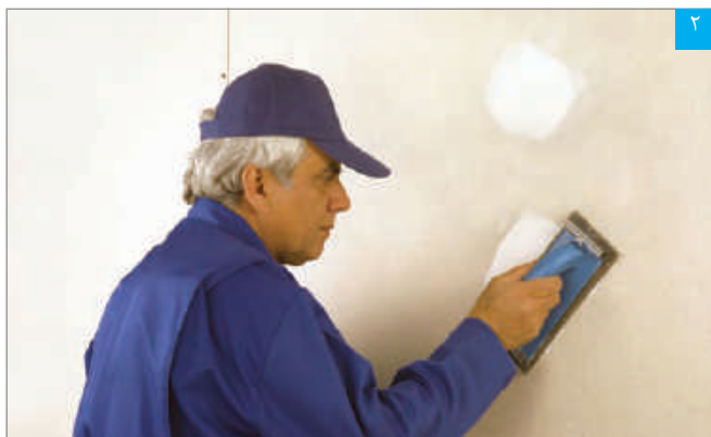
پرداخت سطح بتونه خشک
