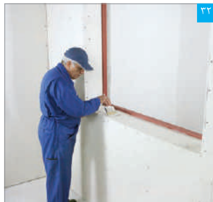
اجرای پرایمر بر روی سطح پنل
