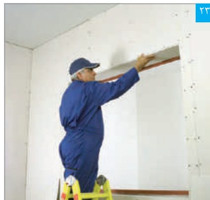
۲۳ تنظیم لبه های پنل در محل کنج
