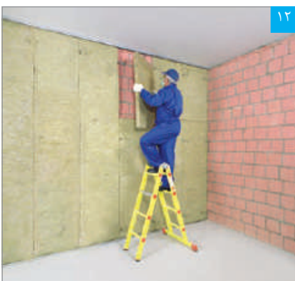
۱۲ اجرای عایق پشم معدنی
