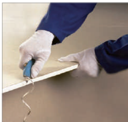
اجرای پخ با تیغ برش
