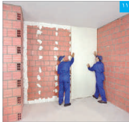
۱۱ استقرار پنل بر روی دیوار زمینه
