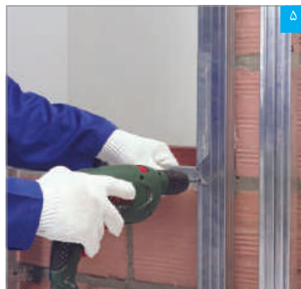
اتصال سازه قاب‌بندی به سازه قائم به وسیله پرچ یا پیچ (به جهت برش ۴۵ درجه توجه شود)
