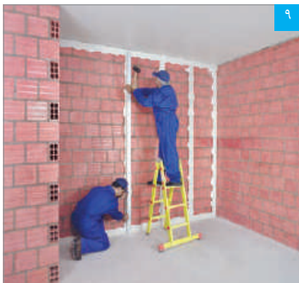
۹ تنظیم نهایی کرم نصب شده با شمشه و چکش لاستیکی
