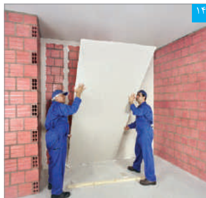
۱۴ پنل به سادگی توسط دو نفر قابل بلند کردن است
