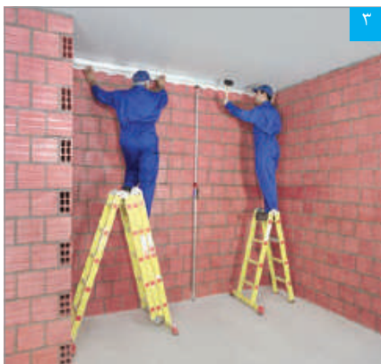
۳ نصب و تنظیم کرم بالا با شمشه و چکش لاستیکی
