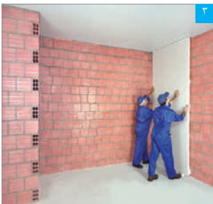
۳ استقرار پنل بر روی دیوار زمینه
