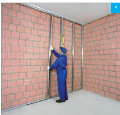
اجرای استاداها (به صورت شاقولی)
