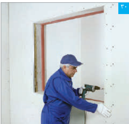
اتصال پنل نواری به سازه قائم
