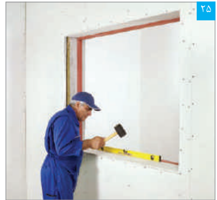
تنظیم پنل نواری (تراز کردن)
