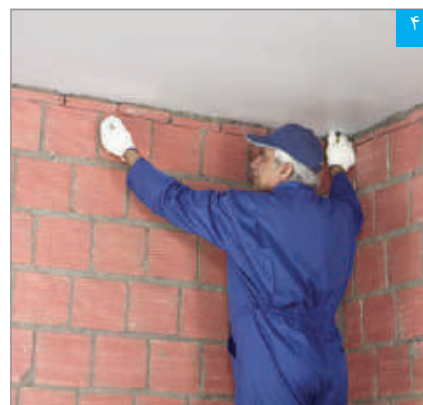
علامت‌گذاری مسیر لایه پوششی بر روی سقف (با استفاده از ریسمان رنگی)
