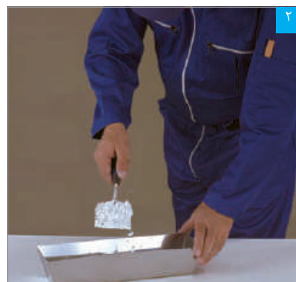
ریختن پودر بتونه در آب
