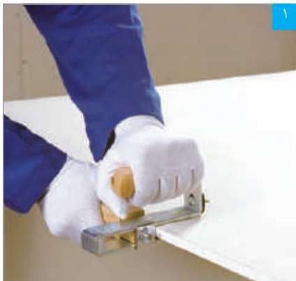
برش پنل با دستگاه برش قرقره‌ای
