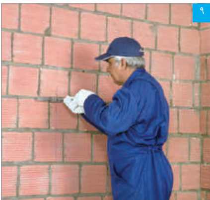
۹ نصب براکت بر روی دیوار زمینه
