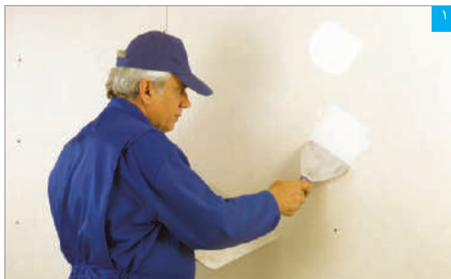
اجرای بتونه در محل پیچ‌ها
