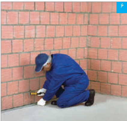
۶ نصب سازه هادی کف
