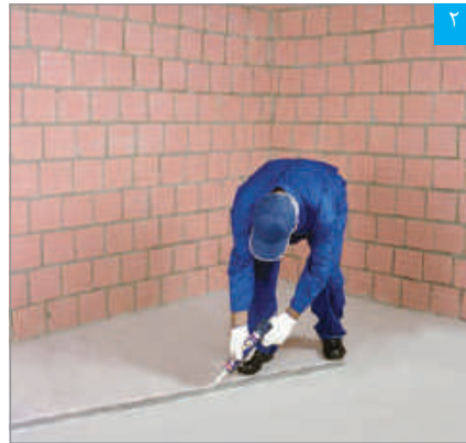
۲ اجرای دو ردیف خمیر درزبند (یا نوار عایق) بر پشت سازه‌های هادی کف و سقف
