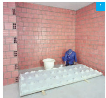
۱ اجرای چانه‌های چسب گچی پنل (پرفلیکس) بر پشت پنل مرکب PS
