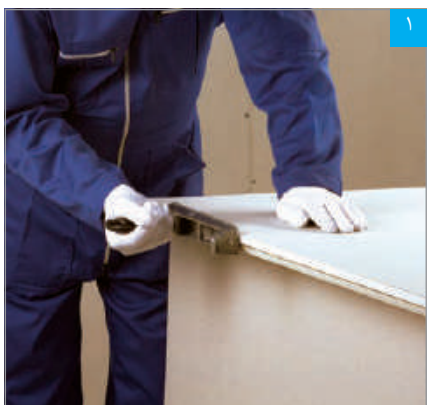
پرداخت لبه برش‌خورده با رنده
