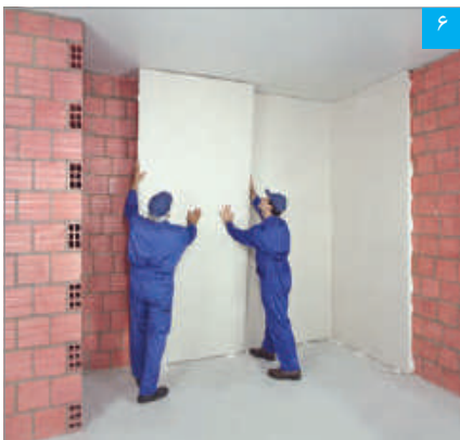
۶ استقرار پنل بر روی دیوار زمینه
