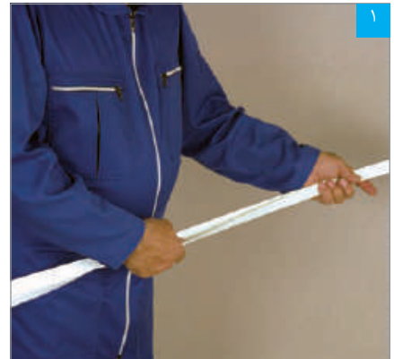
خم کردن نوار درزگیر با دست
