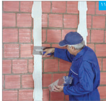
۱۱ اجرای لایه بتونه درزگیر بر روی کرم‌ها با استفاده از ماله دندانه دار
