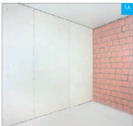
دیوار پوششی تکمیل شده
