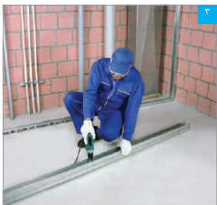
اجرای استادهای دوتایی
