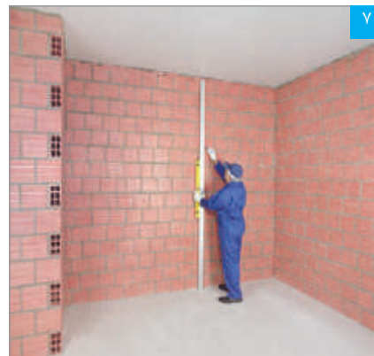
مشخص کردن محل اجرای چانه‌های چسب گچی پنل (پرفلیکس) بر روی دیوار زمینه
