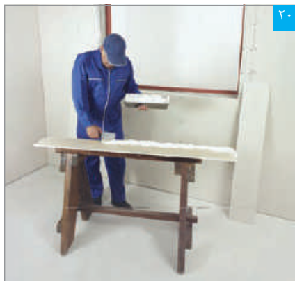
۲۰ اجرای چسب گچی پنل (پرفلیکس) بر پشت پنل نواری (برای پوشش کاری ناحیه داخلی دور بازشوی پنجره)
