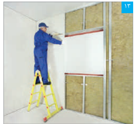
۱۳ برش پنل با استفاده از اره
