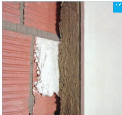
۱۴ ضخامت چانه چسب گچی پنل (پرفلیکس) پس از نصب و فشردن پنل باید حداقل ۵ میلی‌متر باشد
