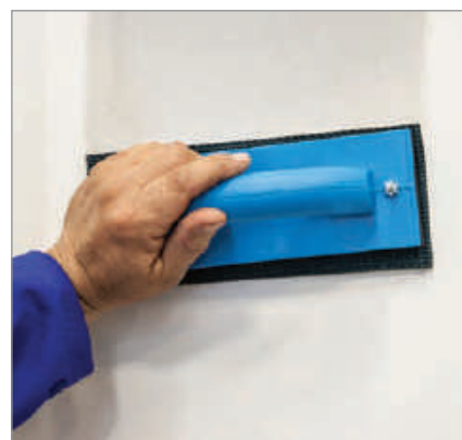
مرطوب کردن سطح دیوار با اسفنج نمدار
