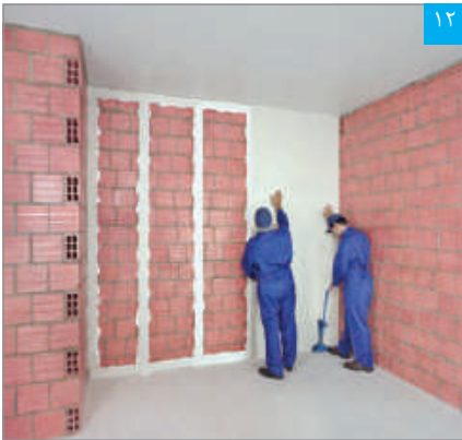
۱۲ نصب پنل با استفاده از جک نگهدارنده
