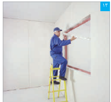
۱۳ استقرار پنل نواری در ناحیه داخلی دور بازشوی پنجره
