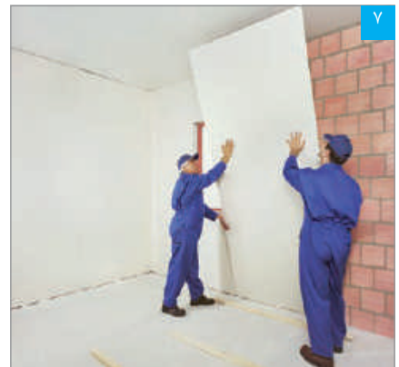
۷ استقرار پنل بر روی دیوار زمینه
