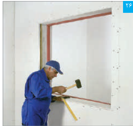
تنظیم پنل نواری (گونیا کردن)
