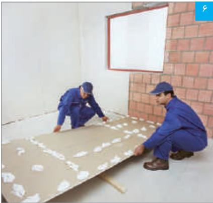
۶ به نحوه اجرای چسب گچی پنل (پرفلیکس) در محل بازشوی پنجره توجه شود
