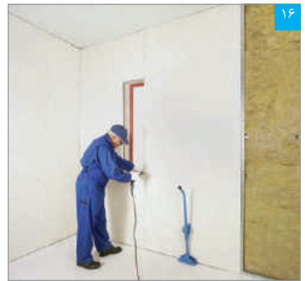
۱۶ نصب پنل بر روی زیرسازی
