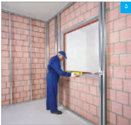
۵ تنظیم رانر قاب‌بندی تحتانی به وسیله تراز
