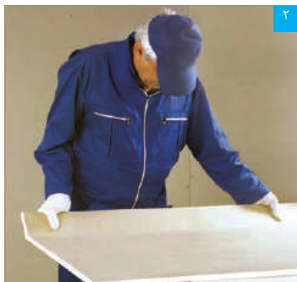
شکستن پنل در محل برش
