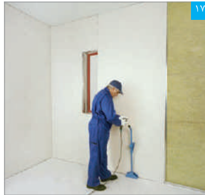
۱۷ نصب پنل بر روی زیرسازی
