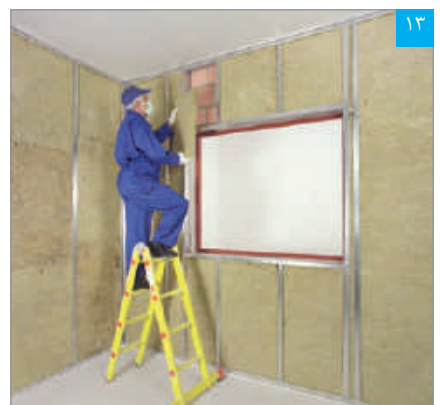
۱۳ اجرای عایق پشم معدنی
