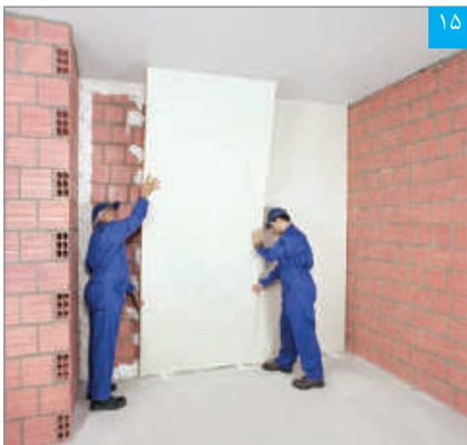
۱۵ پنل‌ها بر روی محور مرکزی ردیف‌های چسب گچی پنل (پرفلیکس) مستقر می‌شوند
