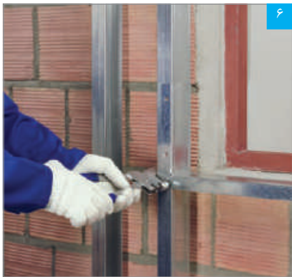
۶ اتصال رانر قاب‌بندی تحتانی به استاد به وسیله پانچ، پرچ یا پیچ (به جهت برش ۴۵ درجه توجه شود)
