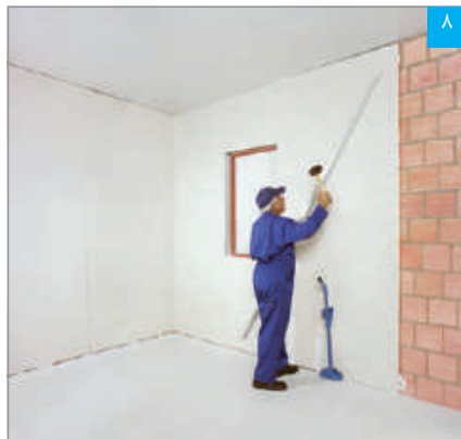
۸ نصب و تنظیم پنل بر روی دیوار زمینه
