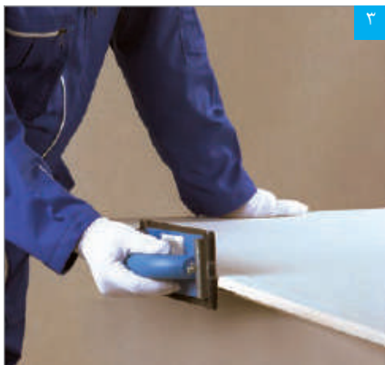
پرداخت وجه عمودی لبه پخ‌خورده با ساب‌ماله‌ای
