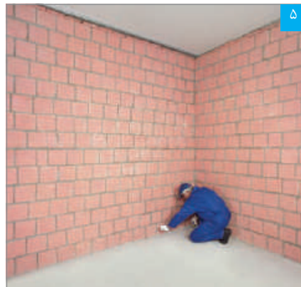
۵ مشخص کردن محل نصب سازه هادی کف با ریسمان رنگی
