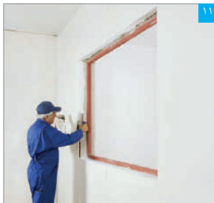
۱۱ اجرای چسب گچی پنل (پرفلیکس) بین پنل و دیوار بنایی (دور تا دور بازشوی پنجره)
