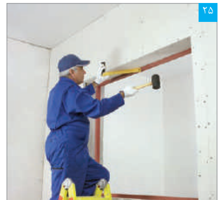
۲۵ تنظیم پنل نواری (گونیا کردن)
