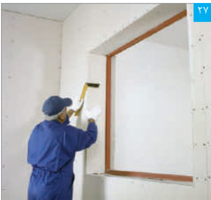
۲۷ تنظیم پنل نواری (گونیا کردن)
