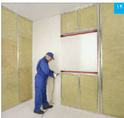
۱۴ نصب پنل بر روی زیرسازی
