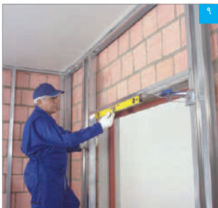
۹ تنظیم رانر قاب‌بندی فوقانی به وسیله تراز
