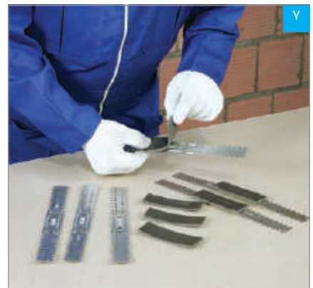
۷ نصب قطعات فوم (عایق) بر پشت براکتها
