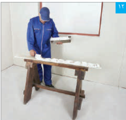
۱۲ اجرای چسب گچی پنل (پرفلیکس) بر پشت پنل نواری (برای پوشش کاری ناحیه داخلی دور بازشوی پنجره)
