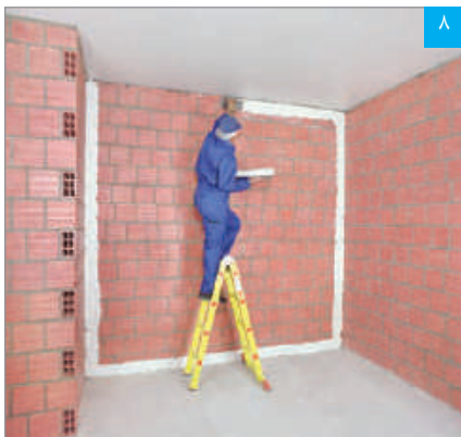
اجرای چسب گچی پنل (پرفلیکس) به صورت نوار پیوسته در حاشیه پیرامونی دیوار زمینه
