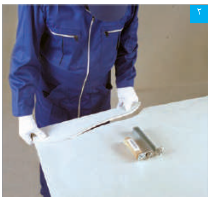
جداکردن پنل از محل برش
