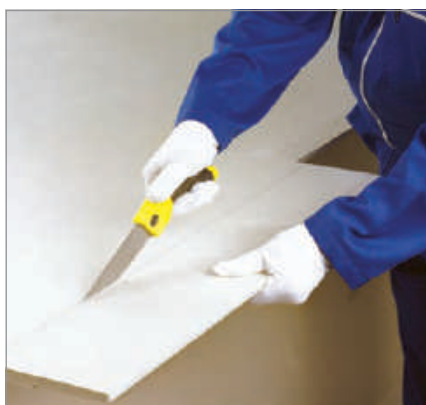
برش پنل با اره دستی
