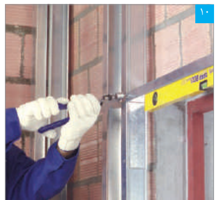
۱۰ اتصال رانر قاب‌بندی فوقانی به استاد به وسیله پانچ، پرچ یا پیچ (به جهت برش ۴۵ درجه توجه شود)
