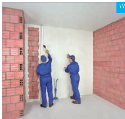
۱۷ تنظیم نهایی پنل نصب شده با شمشه و چکش لاستیکی
