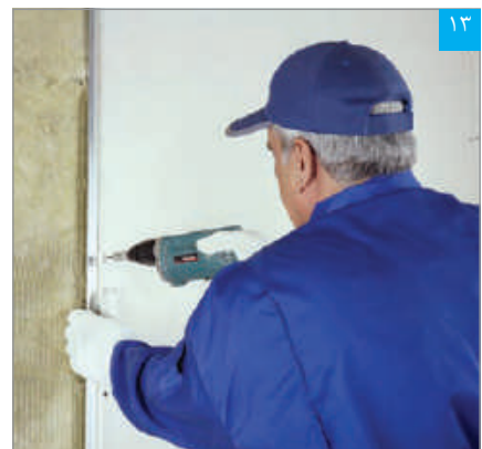
توجه: پنل‌ها باید در جهتی نصب شوند که لبه آزاد آن‌ها به سمت دهانه باز استادها قرار گیرد
