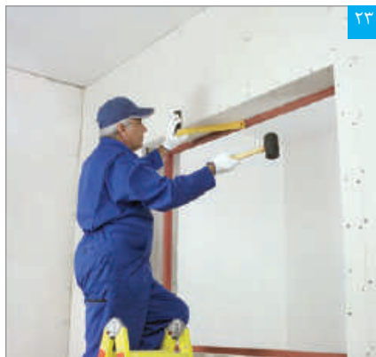
۲۳ تنظیم پنل نواری (گونیا کردن)
