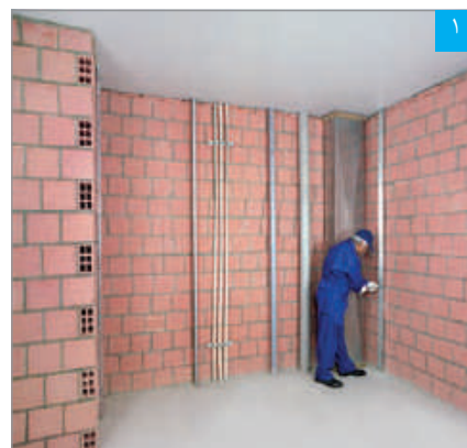
۱ نصب اولین رانر بر روی ساختار جانبی
