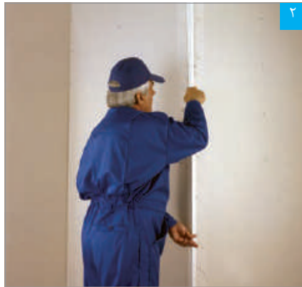
قرار دادن نوار محافظ گوشه بر روی بتونه
