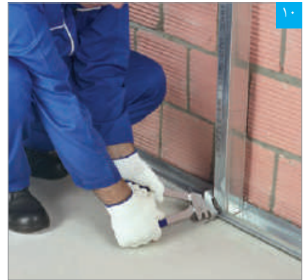
اتصال و تثبیت استادها به رانرها (به وسیله پانچ، پرچ یا پیچ)
