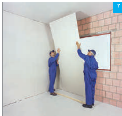
استقرار پنل بر روی دیوار زمینه
