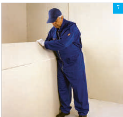
شکستن پنل در محل برش
