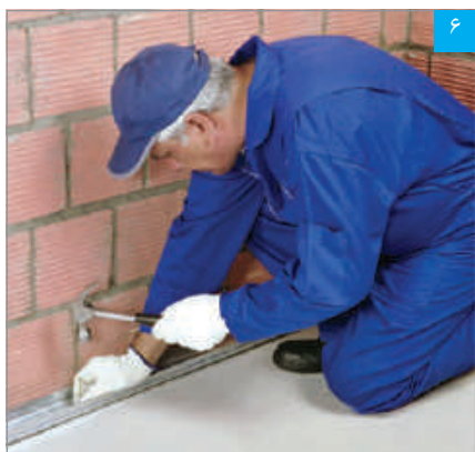
نصب رانر کف
