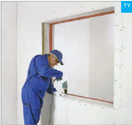
اتصال پنل نواری به سازه قاب‌بندی تحتانی
