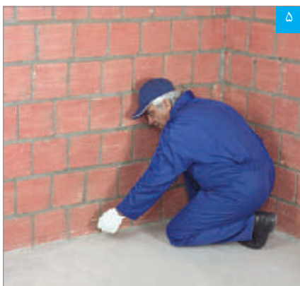
علامت‌گذاری مسیر لایه پوششی بر روی کف (با استفاده از ریسمان رنگی)
