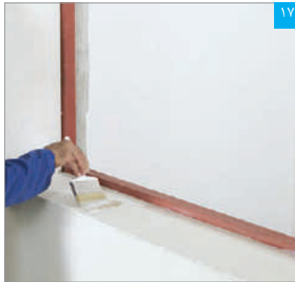
اجرای پرایمر بر روی سطح پنل
