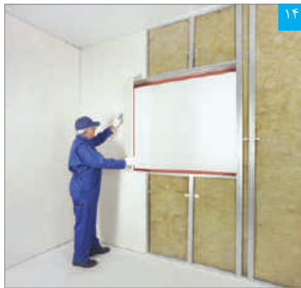
۱۴ برش پنل با استفاده از تیغ برش
