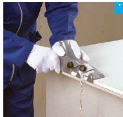
اجرای پخ با پخ‌زن
