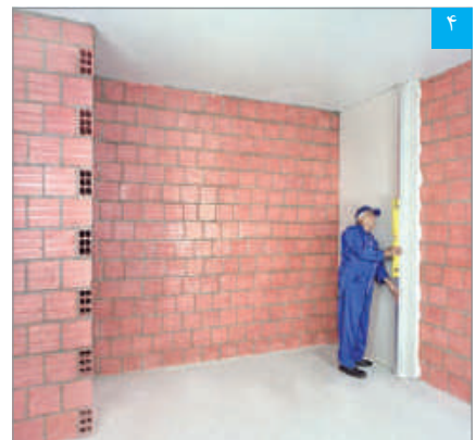
۴ بررسی تراز و تنظیم بودن پنل نصب شده با استفاده از شمشه و تراز
