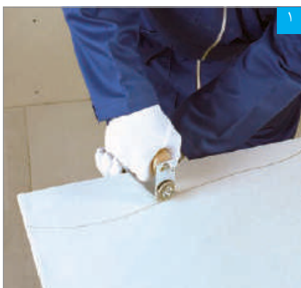
اجرای برش موج‌دار با دستگاه برش قرقره‌ای
