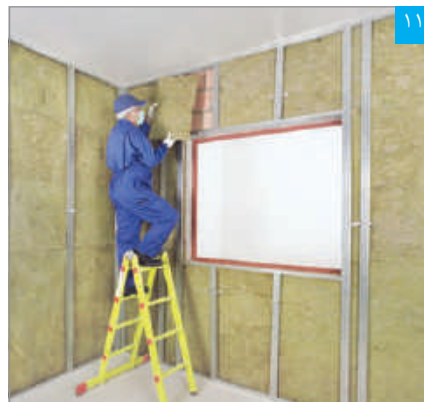
اجرای عایق پشم‌معدنی
