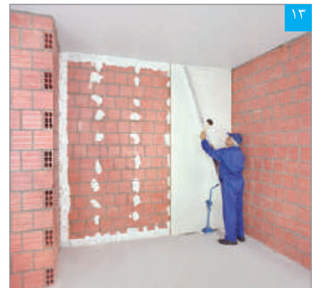
۱۳ تنظیم نهایی پنل نصب شده با شمشه و چکش لاستیکی
