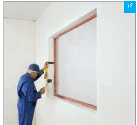
نصب و تنظیم پنل نواری
