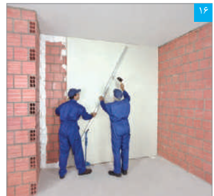
۱۶ نصب و تنظیم پنل، با پنل نصب شده مجاور
