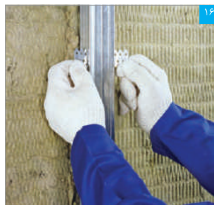
خم کردن طول اضافه بال‌های براکت (توجه: لایه عایق در پشت سازه‌ها قرار می‌گیرد)
