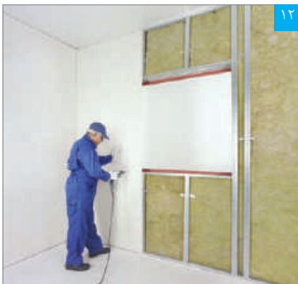
نصب پنل بر روی زیرسازی
