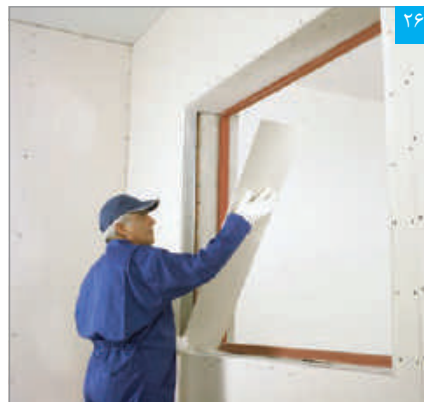
۲۶ استقرار پنل نواری در ناحیه داخلی دور بازشوی پنجره
