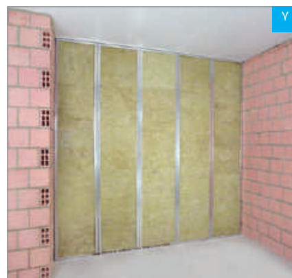
لایه عایق تکمیل شده
