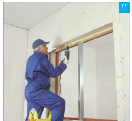
۲۲ اتصال پنل نواری به سازه قاببندی فوقانی
