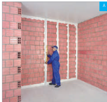
۸ بررسی تراز و تنظیم بودن کرم نصب شده با استفاده از شمشه و تراز
