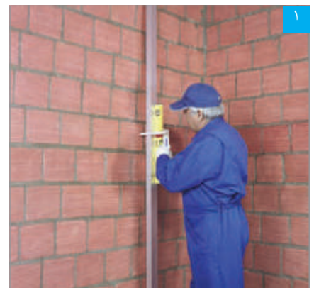
۱ اندازه‌گیری میزان ناهمواری دیوار
