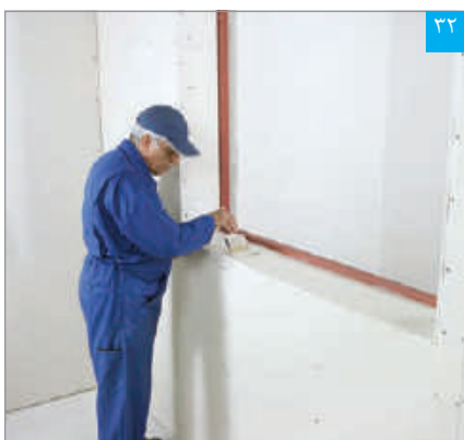
اجرای پرایمر بر روی سطح پنل
