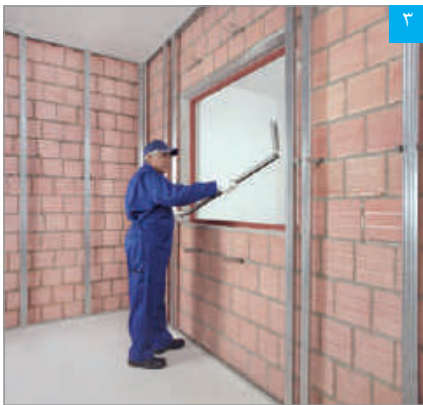
استقرار سازه قاب‌بندی تحتانی (به جهت خم‌ها توجه شود)
