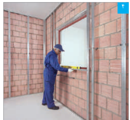
تنظیم سازه قاب‌بندی به وسیله تراز
