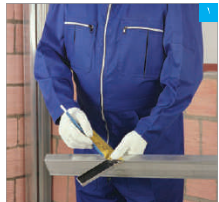
علامت گذاری بر روی رانر قاب‌بندی بازشوی پنجره (به اندازه ۲۰ سانتی‌متر و به صورت فارسی بر)
