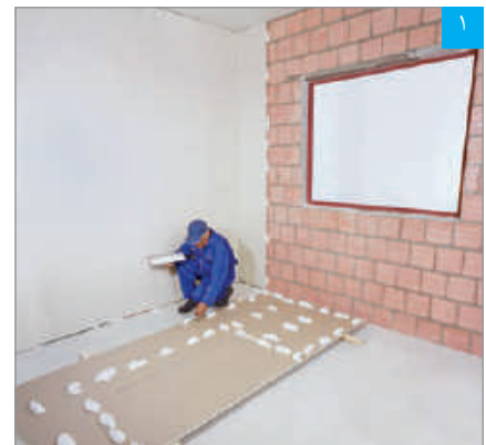
اجرای چانه‌های چسب گچی پنل (پرفلیکس) بر پشت پنل
