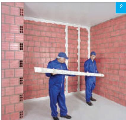
۶ چانه‌های چسب گچی پنل (پرفیکس) در فواصل حداکثر ۳۵ سانتی‌متر (مرکز به مرکز) بر پشت کرم ها قرار می‌گیرند
